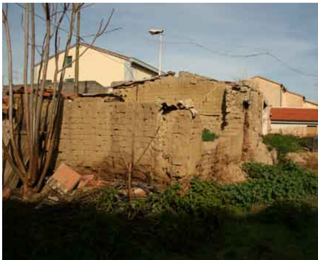
L'intervento sui ruderi in ambito urbano presuppone l'attenta valutazione del manufatto e dell'assetto al suo contorno.
